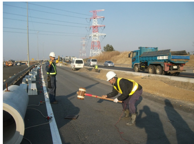
図-3 ハイブリッド表面波探査現場作業写真
