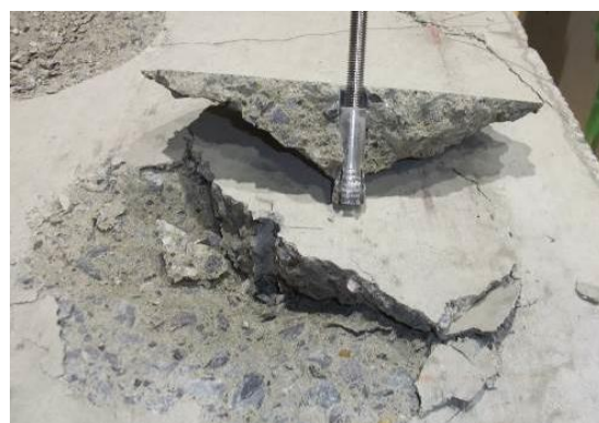
写真-2 コーン破壊の例（試行ケースにおける例）
