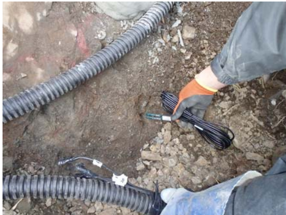
写真-2.2 土壌水分計設置状況
