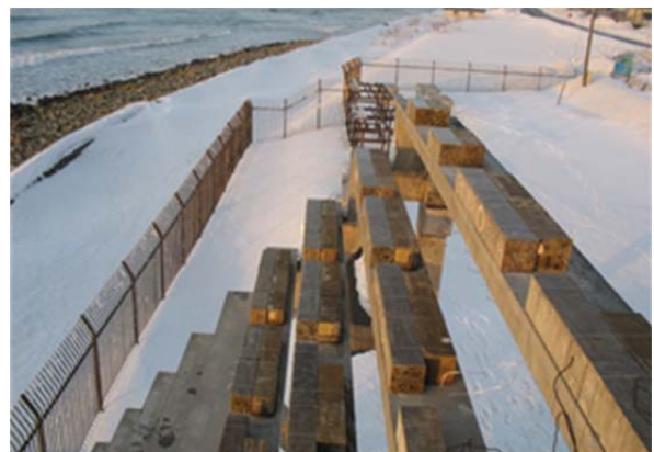
写真-5.1.1 増毛暴露実験場における供試体の据付け状況
