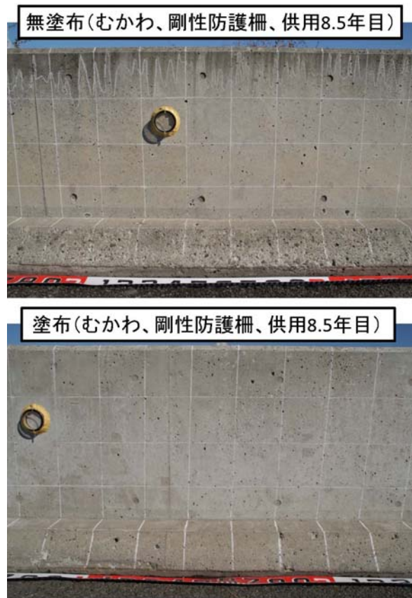
写真-5.1.7 むかわ剛性防護柵の供用8.5年目の状況
