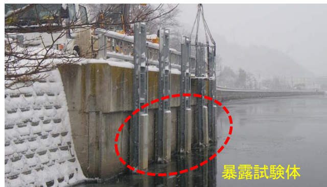
写真-3.2.1 暴露試験体の設置状況(当初)
