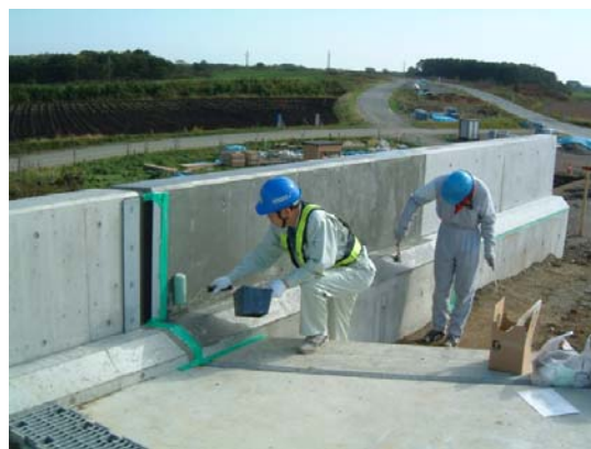
写真-5.1.3 むかわの高規格幹線道路橋剛性防護柵での試験施工状況
