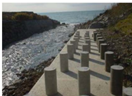
写真-4.1.1 暴露状況
