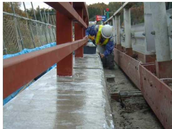
写真-5.1.2 美幌の一般国道道路橋地覆での試験施工状況
