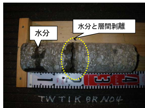
写真-3 ブリスタリングが発生した箇所から採取した無水コア
