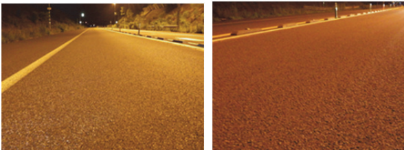
写真-9 名寄美深道の路面状況 (左：機能性 SMA, 右：排水性舗装)
