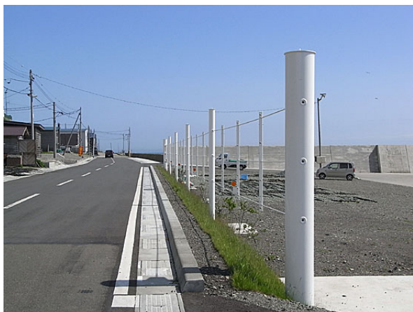
図-5 えりも港における対策施設の設置状況
