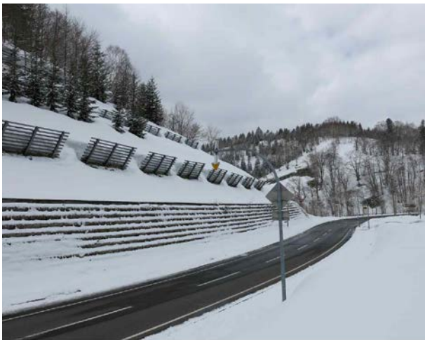
図10 雪圧観測箇所（朱鞠内）
