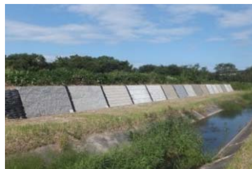
写真 3.2.2 景観実験護岸
