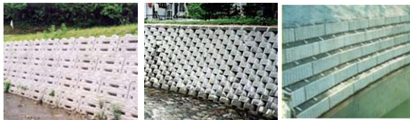
写真 4.2.1 検討対象とした景観パターン (左：穴あき 中：千鳥-穴あき 右：階段)
