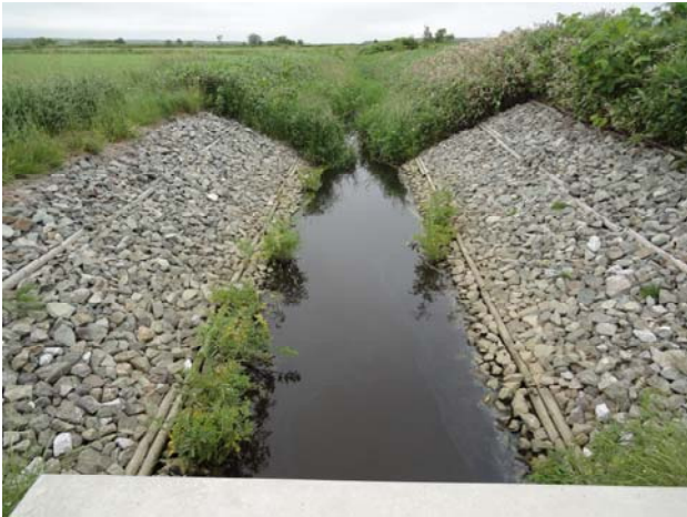
写真-1 整備済排水路の状況
