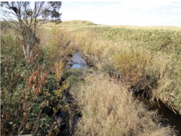
写真-2 未整備排水路の状況
