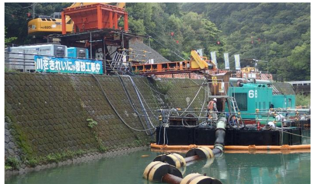
写真-3 Bダム覆砂工事（土砂投入口）
