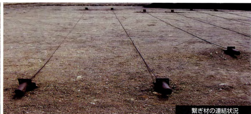
繋ぎ材の連結状況
