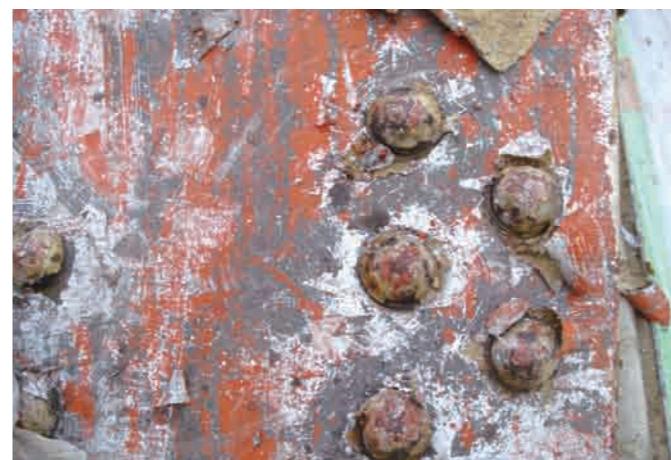
スクレーパーで塗膜を除去。膜厚が約700μmあるので、2回目の塗膜除去作業が必要でした。
