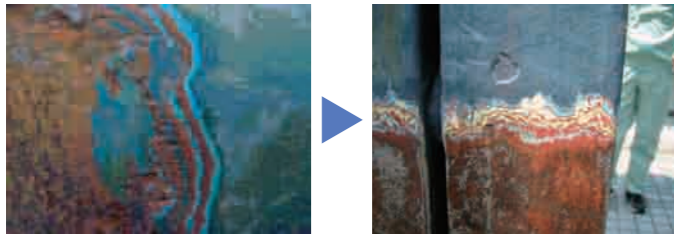
塗膜表面を研磨して塗装履歴や黒皮の有無を確認している例
