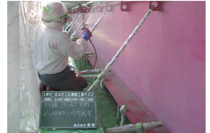
インバイロワンはスプレーにより容易に塗付できました。
