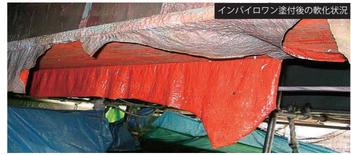
スクレーパーによる塗膜除去作業
