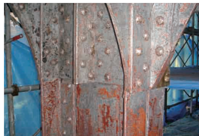
2回目の塗膜の除去作業完了。
