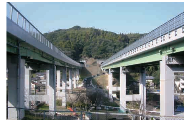
塗替え塗装完了後の金山橋。
