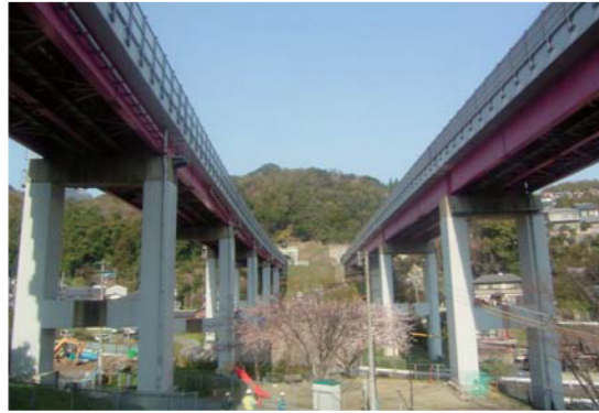
北九州高速4号線 金山橋
