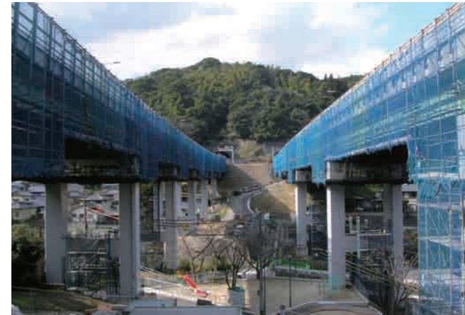
他工法と比べて簡易な防護工で施工できました。
