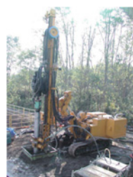
施工確認試験
