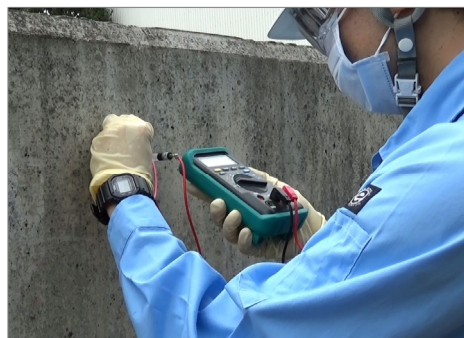
深さ方向の塩分量の調査状況
