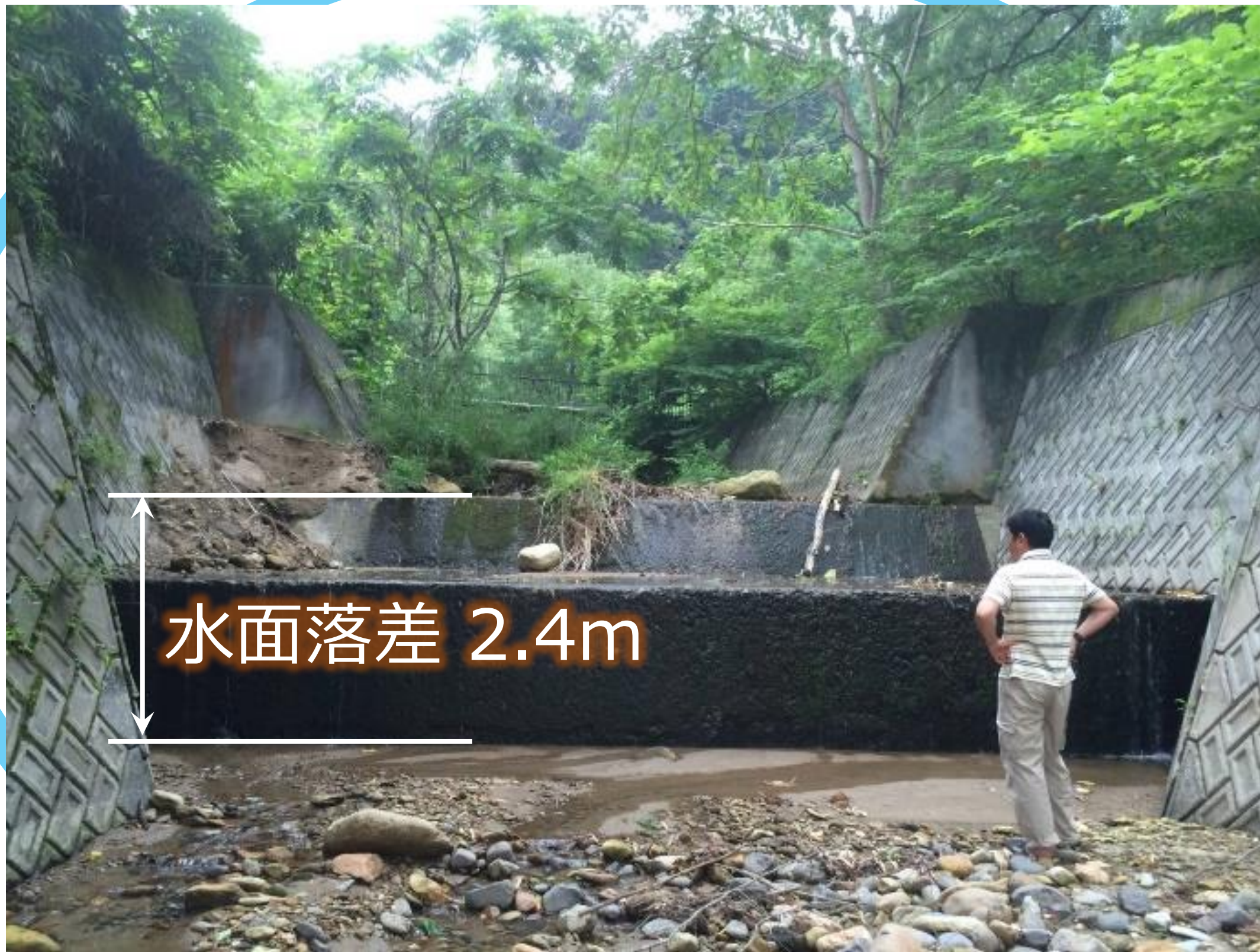
施工前（遡上不可）
