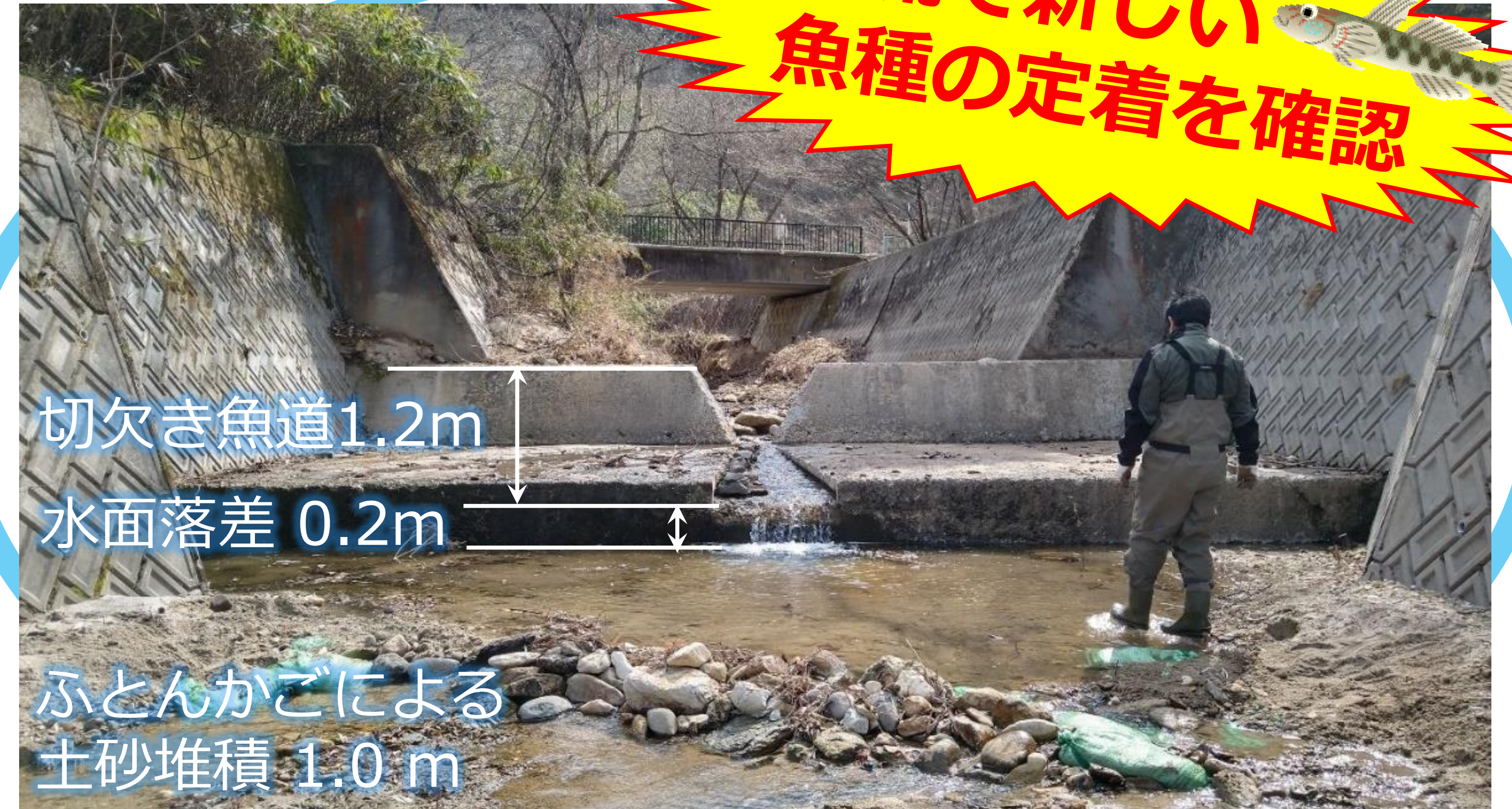
切欠き魚道 完成後
