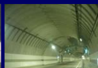
②完成写真
