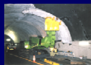
①施工写真
