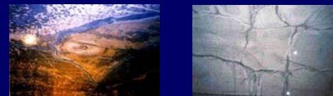
コールドジョイントと横断面目地との組合せでブロック化
