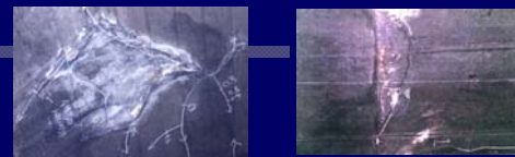
ひび割れと横断面目地との組合せで半月状にブロック化
