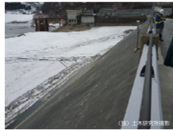
ダム上流面の状況（異常なし）
