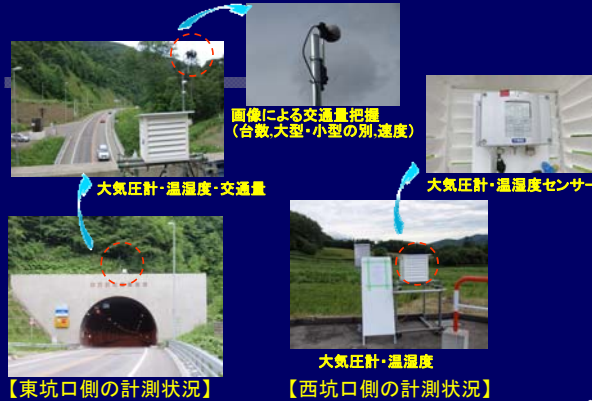
【東坑口側の計測状況】
