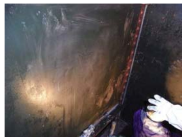
塗膜除去完了
