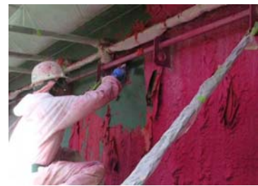
スクレーパーで塗膜除去
