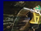
4. NAVシート貼り付け
