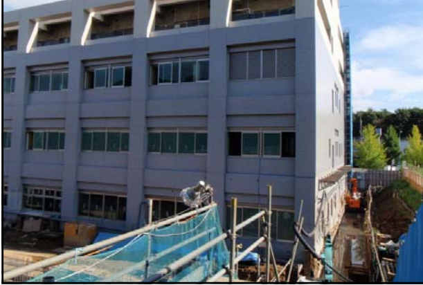
NEW高耐カマイクロパイル 施工事例
