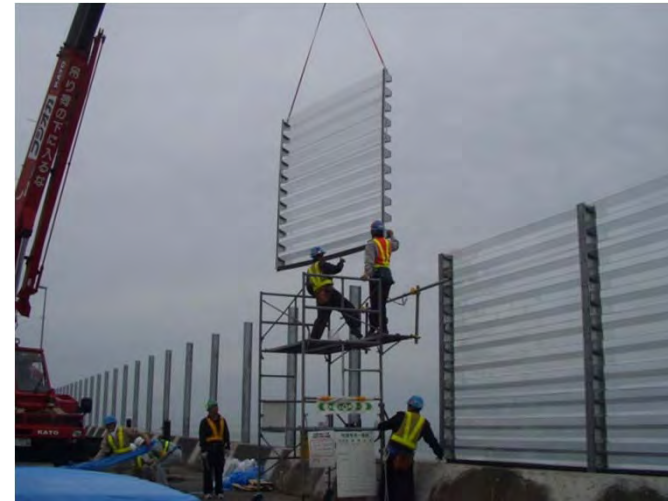
H鋼支柱間に上部より挿入
