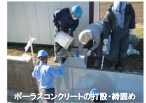
ポーラスコンクリートの打設・締固め
