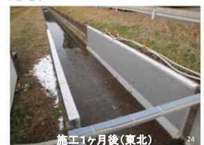
施工1ヶ月後(東北)
