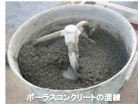
ポーラスコンクリートの混練
