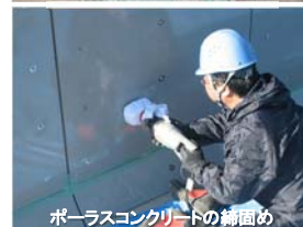
ポーラスコンクリートの締固め
