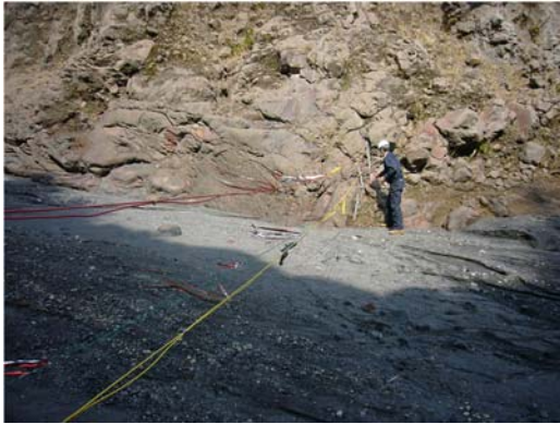
ワイヤーが切れると、張り直さなければならない
