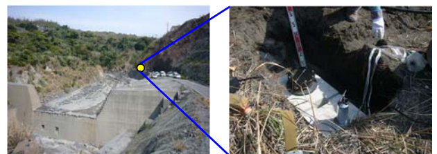
溪岸に振動を観測できるセンサーを設置する。土石流が発する地盤振動をとらえて検知する。
