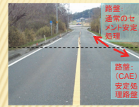
施工 & 写真提供：東亜道路工業(株)
