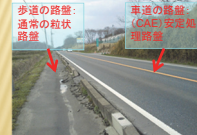
施工 & 写真提供：東亜道路工業(株)
