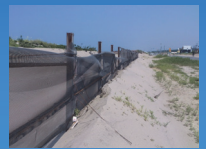
飛砂防止柵(新潟市西区)
