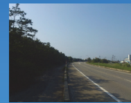
国道沿いの防雪林(胎内市)
