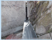
ゴム製排水装置の遊間への挿入状況
