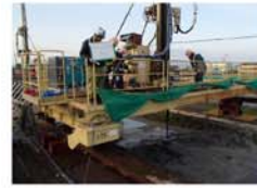
現場施工状況
