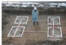
杭頭確認状況 (施工後)
