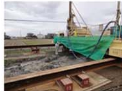
現場打設状況
