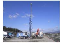
現場施工状況
