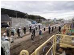
現場視察状況
