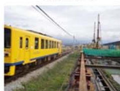
施工状況（鉄道近接）
