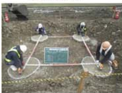
杭頭確認状況
