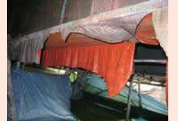
塗膜の除去状況
