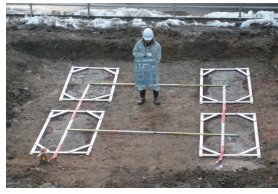
杭頭確認状況 (施工後)
