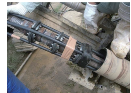
逆流防止材設置状況
