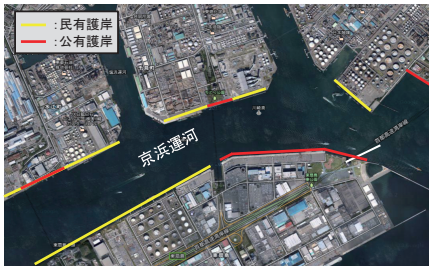
民有護岸と公有護岸の混在と災害の広域化の危険性
