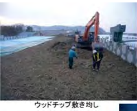
ウッドチップ敷き均し
