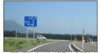
▲道路の路端 (主に左) に設置される『路側式』
