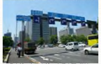
▲多車線：左側車線の走行車両（特に大型車）により、中央寄り車線からの視認性が悪い。
