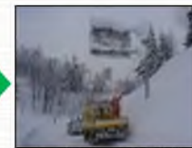
▲F型標識背面の除雪作業
