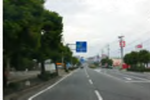
▲歩車道境界に植樹などにより路側の視認性が妨げられている
