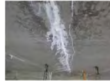
析出物があると、注入出来ないなどの理由でUカット充填工法を採用する事例も多い
