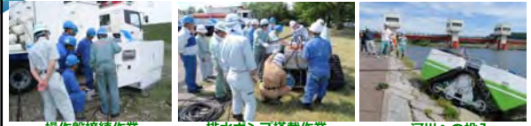
操作盤接続作業
