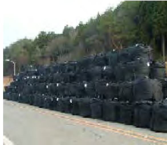
耐候性大型土のう
