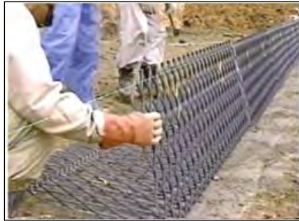
①壁面材の設置 補強材との連結
