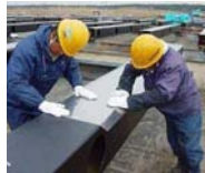
チタン箔シート貼付作業状況
