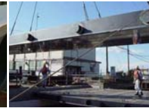
橋梁架設状況
