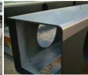
チタン箔シート貼付後状況
