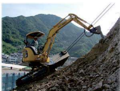
急傾斜地での作業
