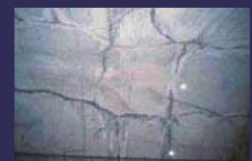
コールドジョイントとひび割れとの組合せでブロック化
