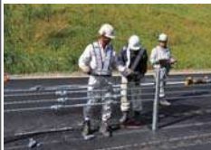
ケーブルカッターで切断
