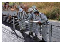
中間ターンバックルの取り付け
