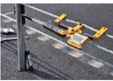
張力計で所定の張力を確認
