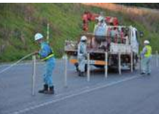
ワイヤロープの設置
