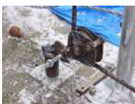
端末基礎にアンカー取り付け
