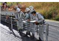
中間ターンバックルの取り付け
