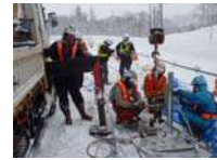
クレーンでワイヤロープを緊張
