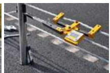
張力計で所定の張力を確認
