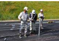
ケーブルカッターで切断
