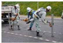
レバーブロックで仮緊張
