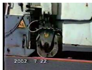
専用施工機械による施工状況
