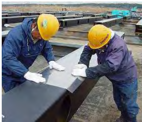
チタン箔シート貼付作業状況
