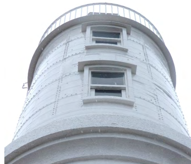
チタン箔シート貼付施工後近影
