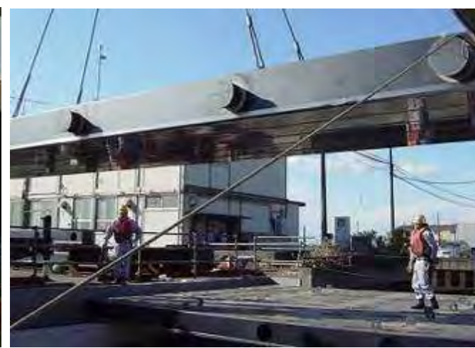
橋梁架設状況
