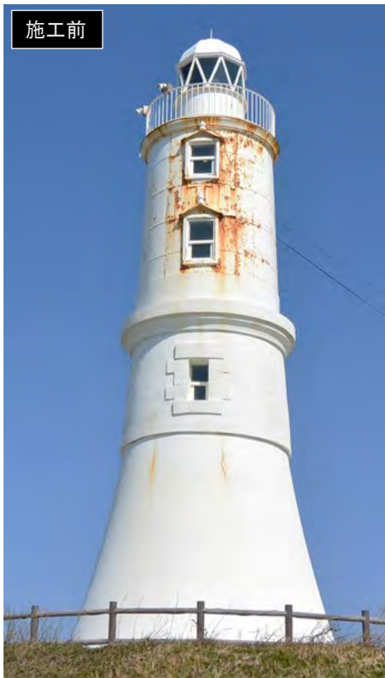
チタン箔シート貼付施工前外観
