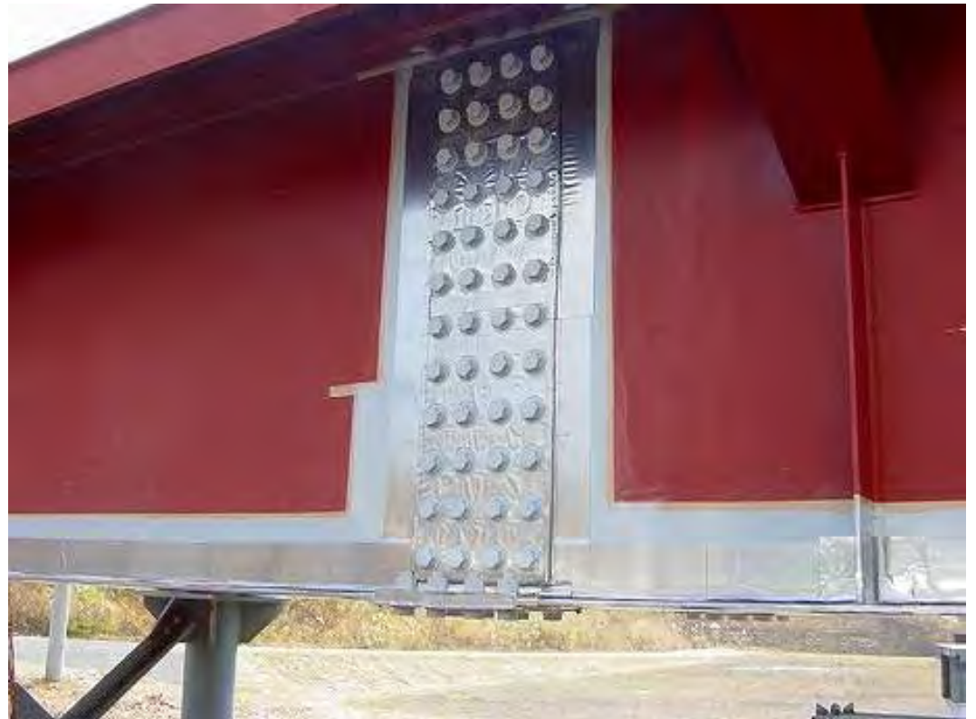
チタン箱シート貼付完了
