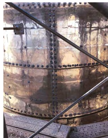
チタン箔シート施工時(塗装前)
