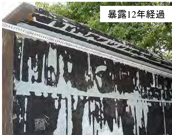
チタン箔シート除去後の状況
