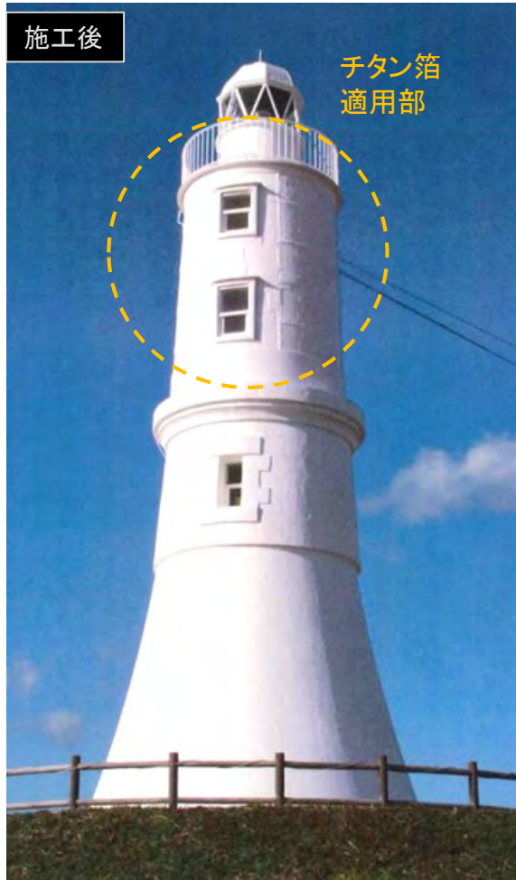
チタン箔シート貼付施工後状況
