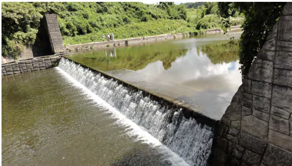
貯砂ダム全景(水位差約1.6m確保可能)
