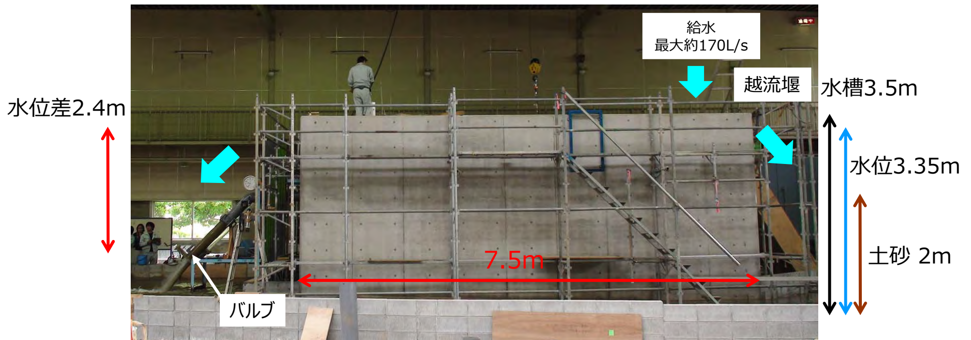
③水槽の水位を維持するための大量の水を要することから循環式で給水を行い、バルブを開けて排砂を行う。
