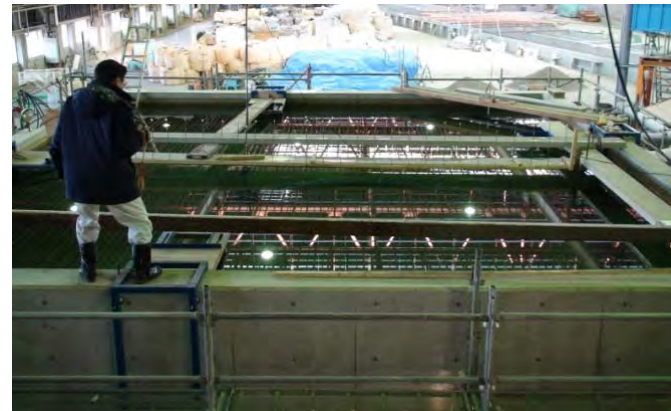
②水槽を満水とし、排砂管をクレーンで吊り下げ
