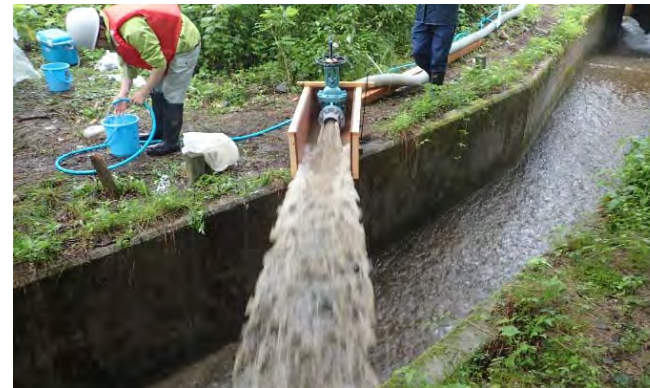
試験中の状況(吐口部)
