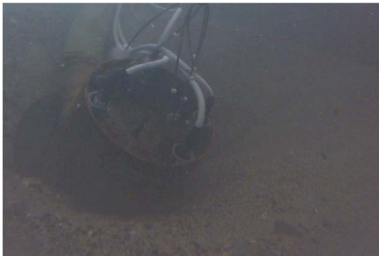
吸引部の土砂吸引の状況(水中)
