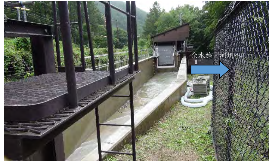
水槽兼沈砂池(排砂時)
