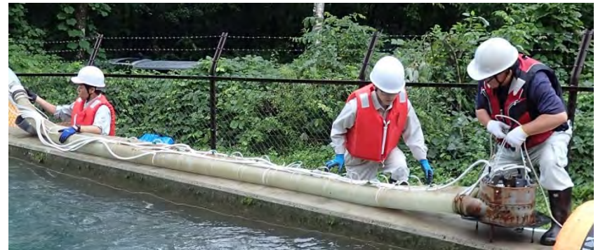
管径100mm潜行吸引式排砂管
