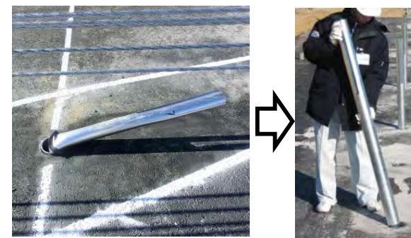
破損した支柱を取り外し、スリーブに挿入
