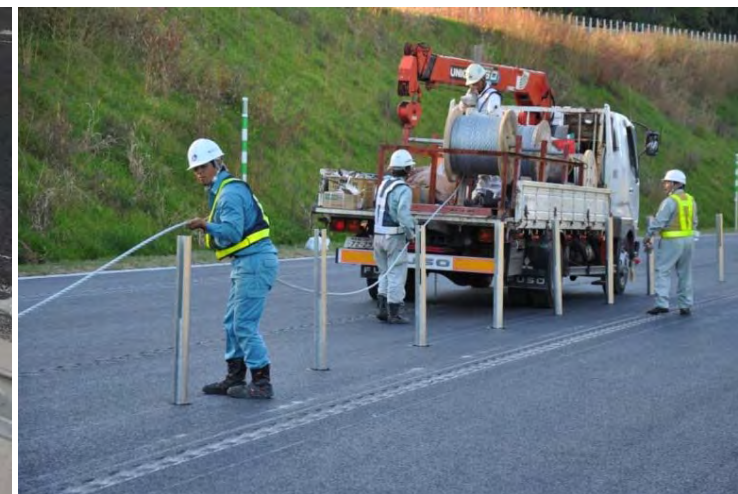
ワイヤロープの設置
