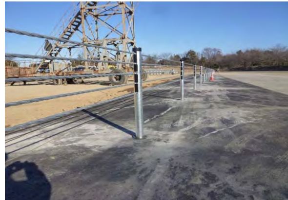
防護柵設置状況 (中間支柱)
