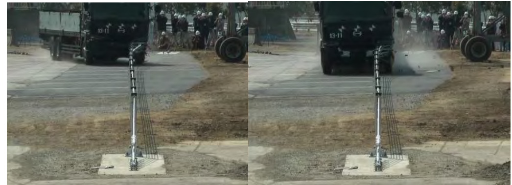
大型車の防護柵衝突後の軌跡(2014年3月)
