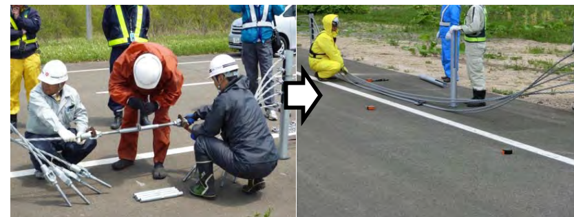
支柱は人力で脱着し、開口部を設置
