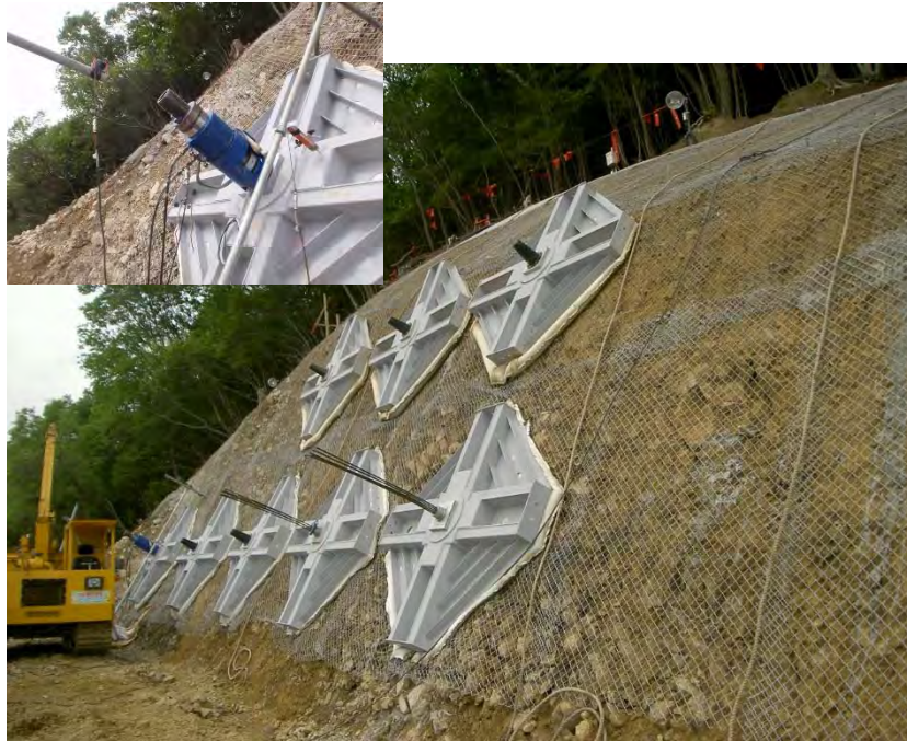
施工時に設置
