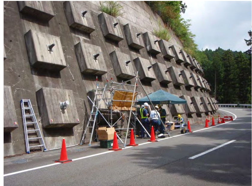
施工後に設置
