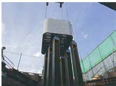
橋梁下部工 橋脚部の埋設型枠
