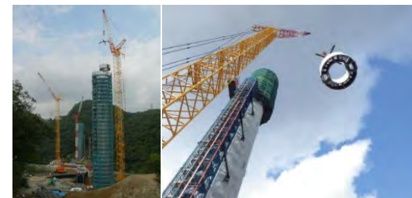
クレーンで吊り込み設置
