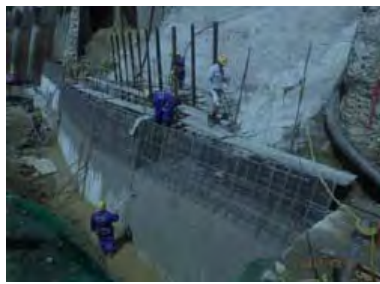
擁壁工 外壁の埋設型枠
