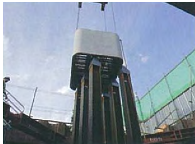
橋梁下部工 橋脚部の埋設型枠
