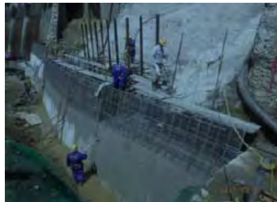
擁壁工 外壁の埋設型枠
