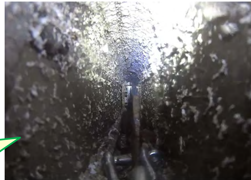
孔の拡大後の孔内部
