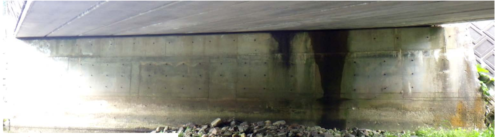
左岸側，排水装置なし
