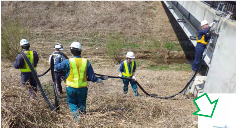
真空引きした後、先導ワイヤに接続
